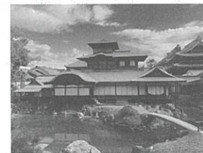
▲屋根葺替が完了した飛雲閣
