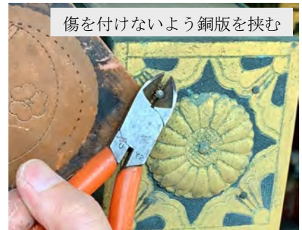
▲ 釘との隙間に工具を入れ釘を抜く様子▲
