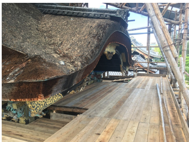
▲ 唐破風前に取り付けられた足場
