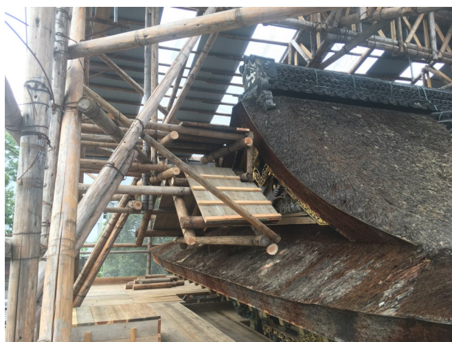
▲ 妻に設置された足場
