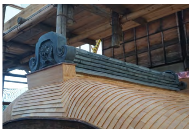
▲瓦が積まれた屋根の棟
