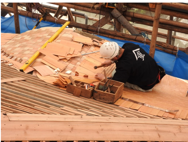
▲ こけら葺作業の様子（二層目西面）
