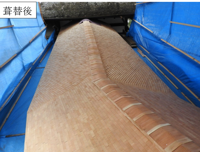
▲ 渡廊下屋根の葺替
