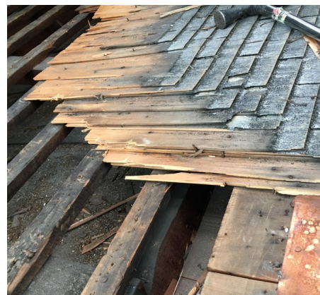
▲ 解体中のこけら葺屋根
