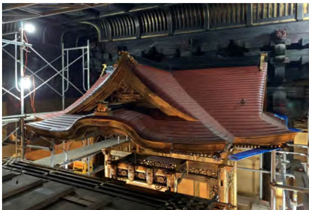
▲ジャッキで屋根を持ち上げている様子
