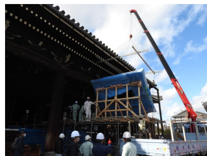
▲ 屋根搬入作業の様子
