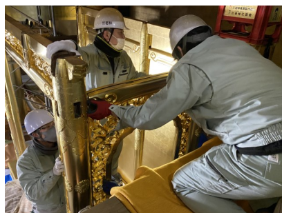
▲ 虹梁取付作業の様子
