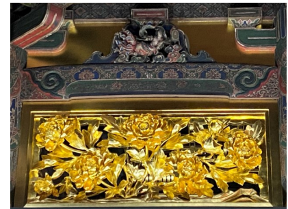
▲ 修理完了 (外陣欄間)
