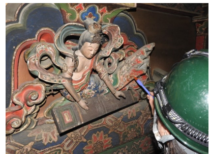
▲ 彩色修理(剥落止め作業)
