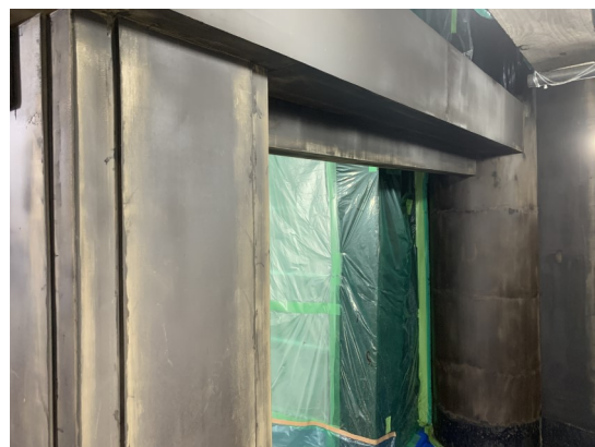
▲ 錆研ぎ作業を終了した柱
