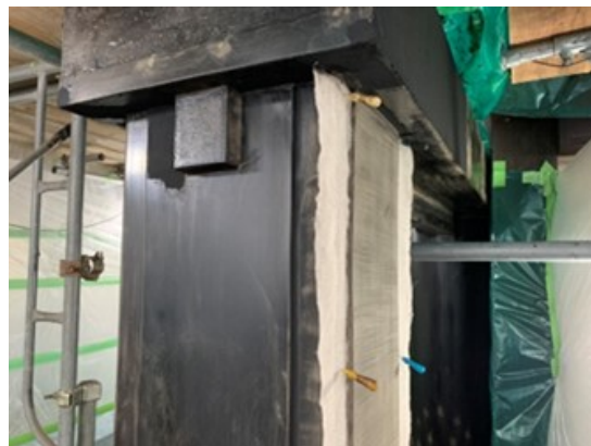
▲ 麻布を張り付けた柱
