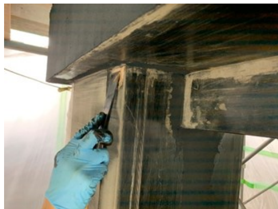
▲ 柱に糊を塗る作業
