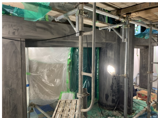
▲ 錆研ぎ作業中の柱
