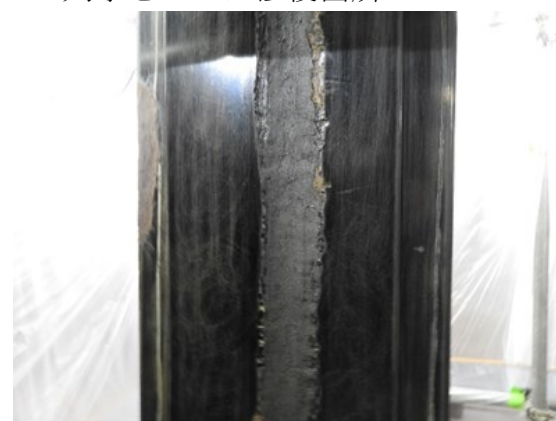
▲ 乾燥後、布着せ作業を行っていく
