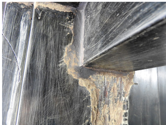
▲ 刻苧を埋めた修復箇所
