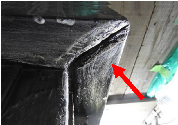
▲ 木材の隙間も埋めていきます
