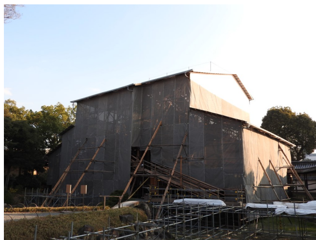
▲修復工事中、素屋根に覆われる
